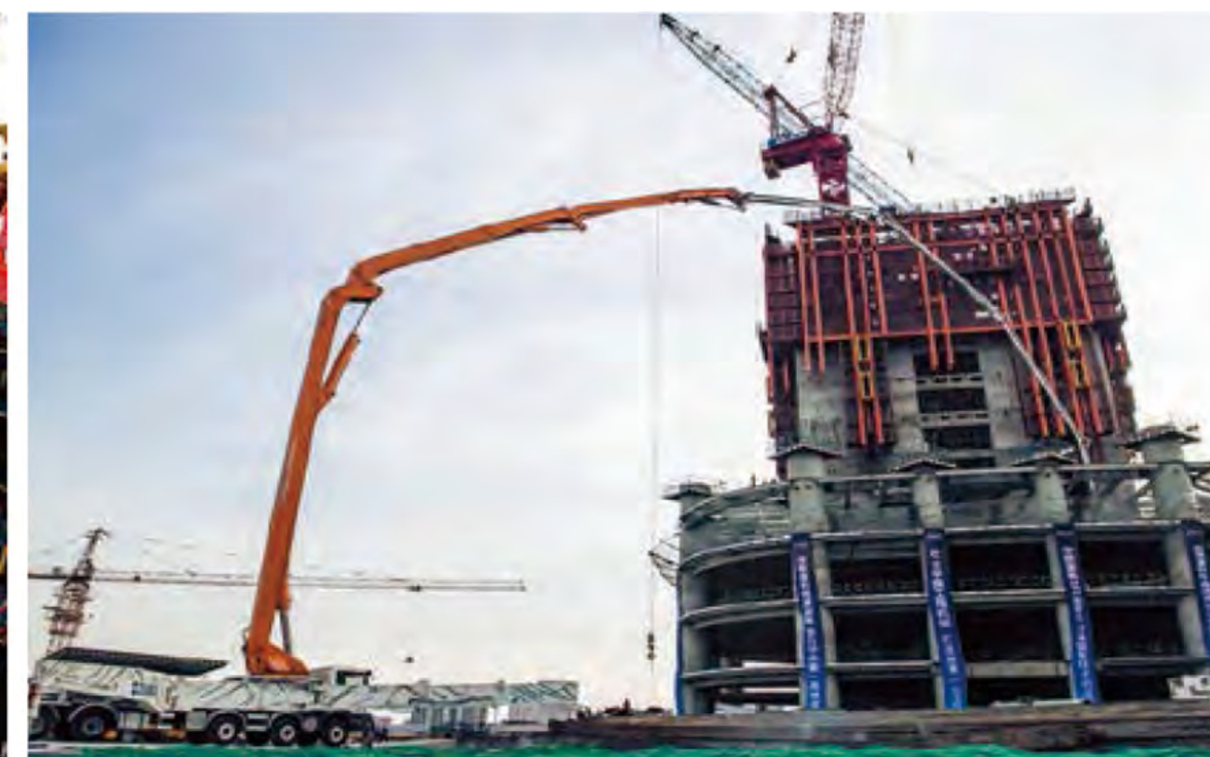
武汉中心 101 米泵车施工现场 101 metre truck pump at Wuhanzhongxin Construcion site
