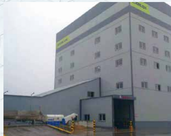
山东青岛中联混凝土环保站
