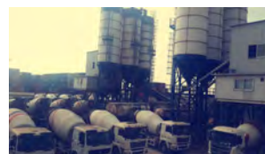
安哥拉：钢结构工程建设项目
