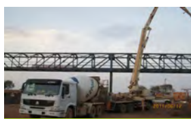
塞内加尔：水泥厂建设项目
